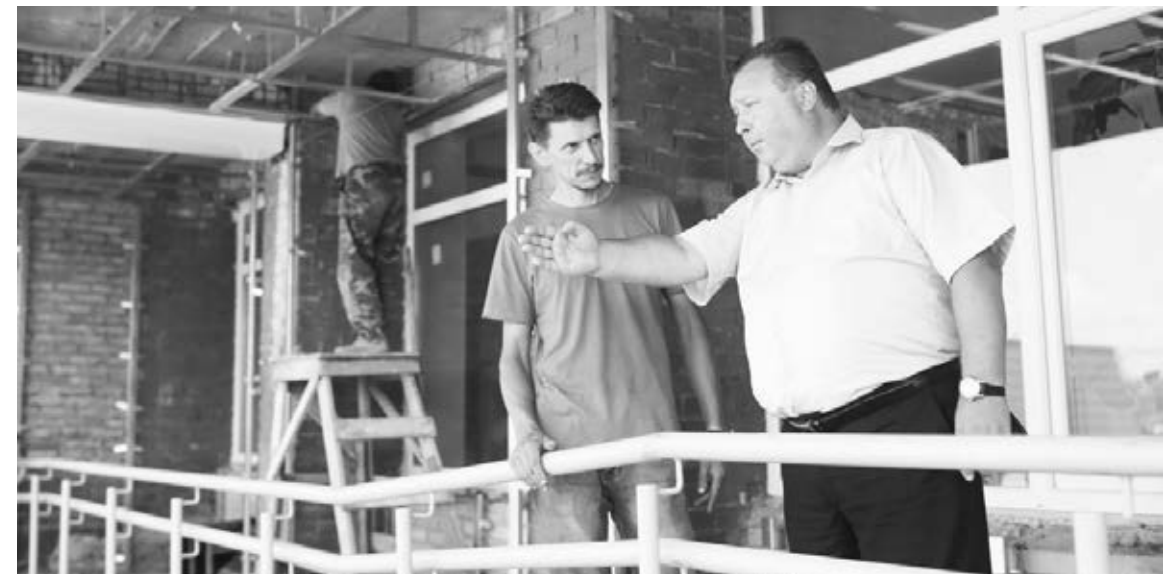
Глава района Борис Егоров контролирует процесс ремонта Озерского ДК
