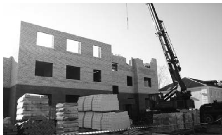
Строительство дома в д. Новое
