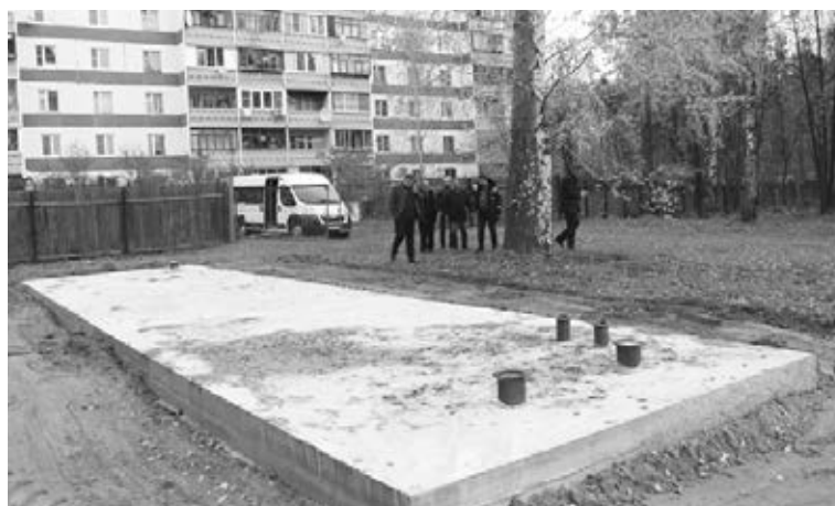
Фундамент под станцию водоочистки
